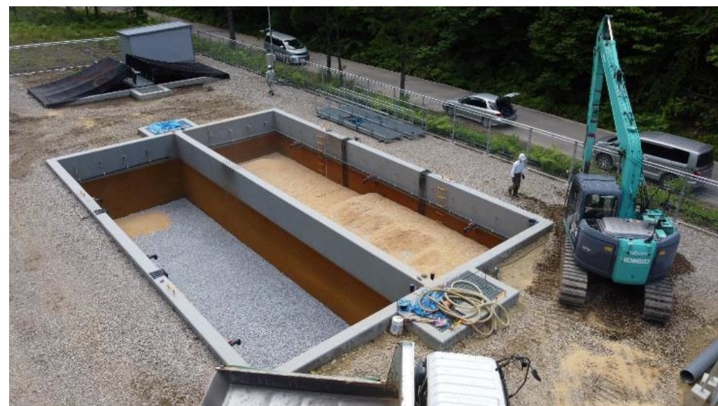
嫌気反応槽内容物混合、充填作業の様子 (1系列は微生物の栄養源として米ぬかを、もう1系列はエタノールを添加)
