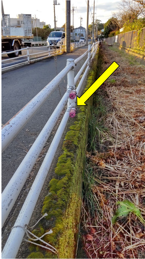
ガードパイプ
