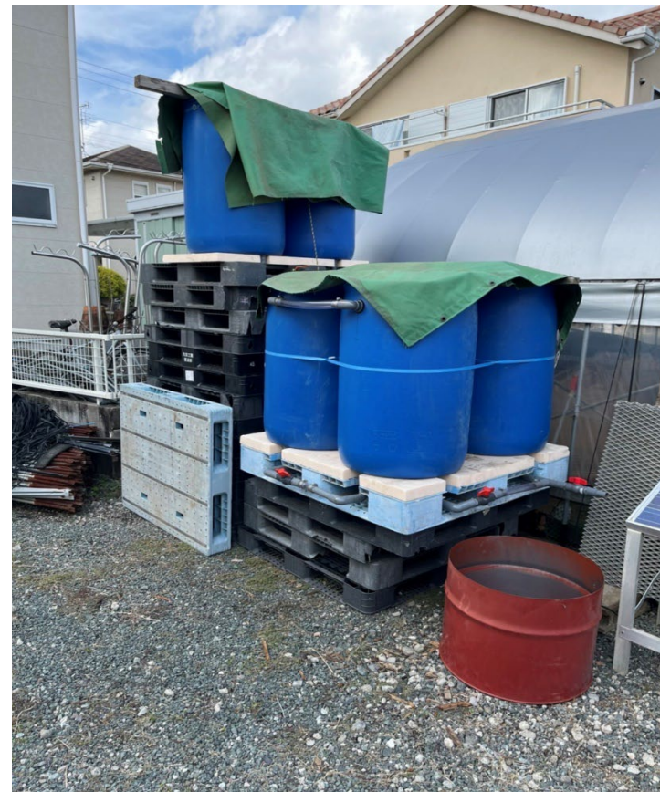
図b.水溶性化処理プラント
