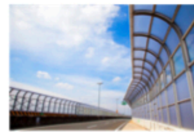
高速道路遮音壁 国内市場規模 約5,000トン/年
